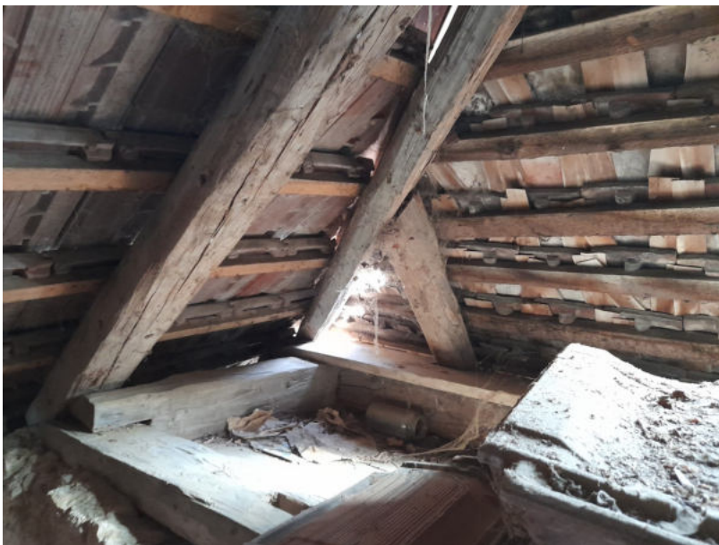
Abbildung 7: Biberschwanzziegel auf Viertelwalm von innen gesehen
