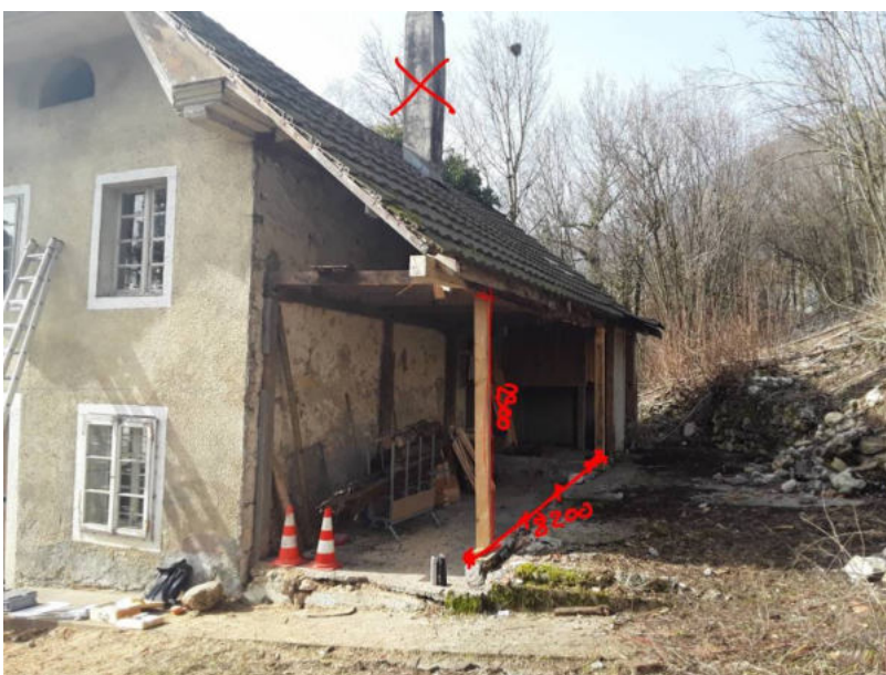
Abbildung 9: Ansicht Anbau Ostseitig
