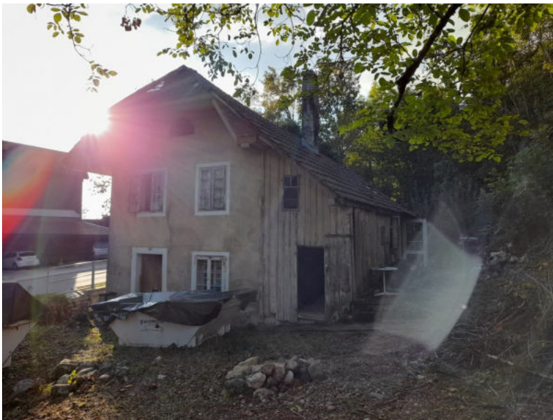
Abbildung 8: Ansicht Anbau Ostseitig
