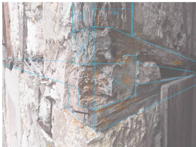
Abbildung 19: Schwellendetail Wand 2 aussen
