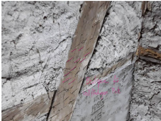
Abbildung 2: Beilspuren für Haftung Innenputz
