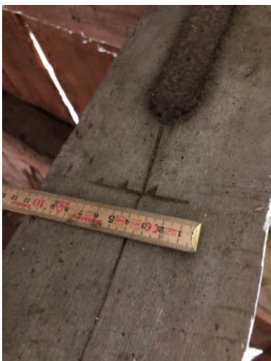
Abbildung 12: Abbundzeichen auf Riegel Bundstrebe: Knotenpunkt Walmseiten-First
