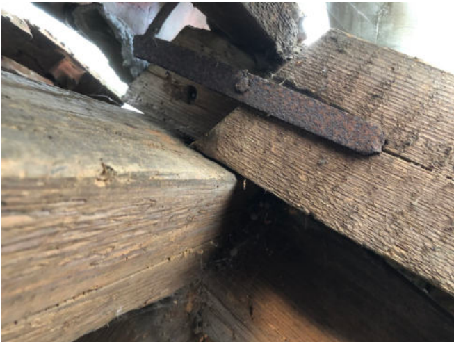
Abbildung 11: Holzverbindung Sparren in der First
