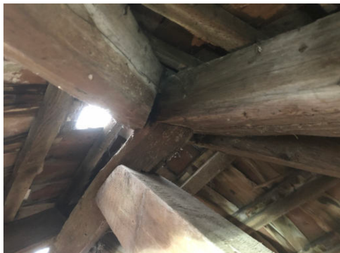
Abbildung 12: Abbundzeichen auf Riegel Bundstrebe: Knotenpunkt Walmseiten-First
