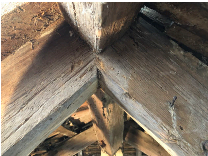
Abbildung 7: Firstdetail Bundstreben
