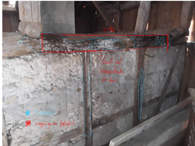
Abbildung 15: Teilstück Gurt Wand 1
