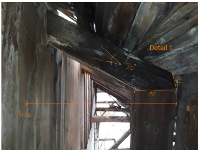
Abbildung 6: Vordachdetail bauzeitlich
