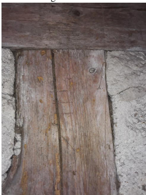
Abbildung 4: Abbundzeichen an Pfosten und Riegel
