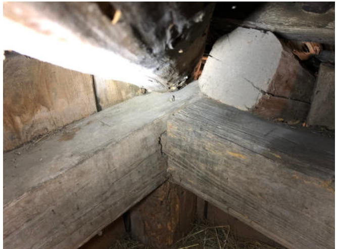
Eckverbindung der Kniestockwand
