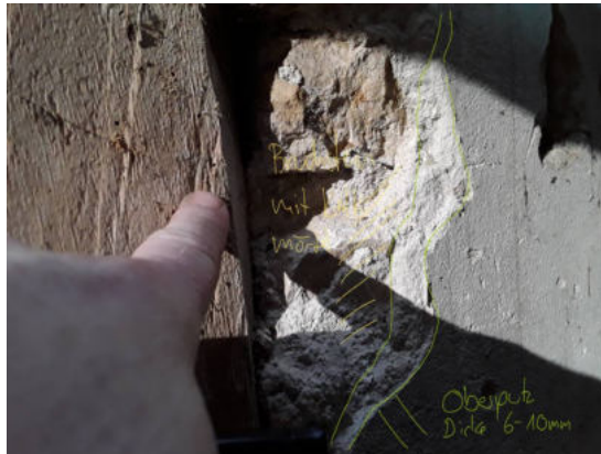
Abbildung 3: Aufbau der Putzschichten
