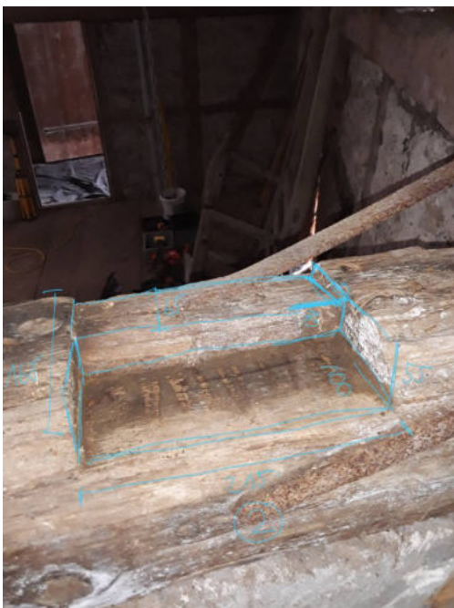
Abbildung 5: Verkämmung der Bundbalken mit den Längswänden
