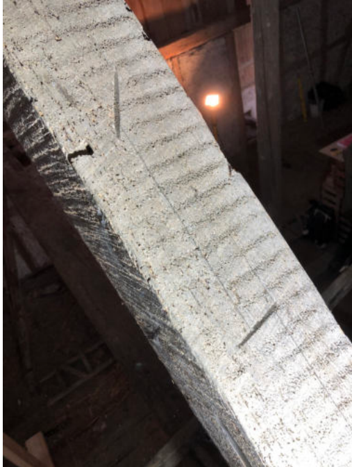
Abbildung 10: 2-seitig Hand gesägte Hölzer mit Abbundzeichen
