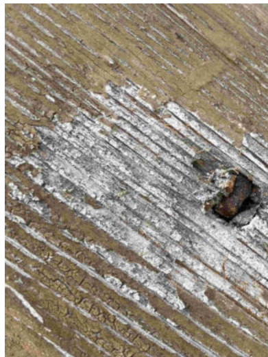
Giebelfassade, Vertikale Schalung
