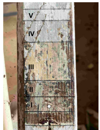
Fensterflügel West, OG; innen
