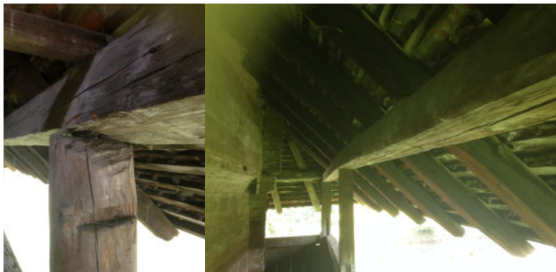
Pfosten ohne Verbindung Verdrehung Fusspfette
