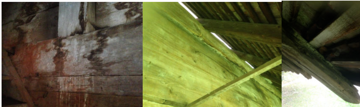
Giebelwand West von Innen
